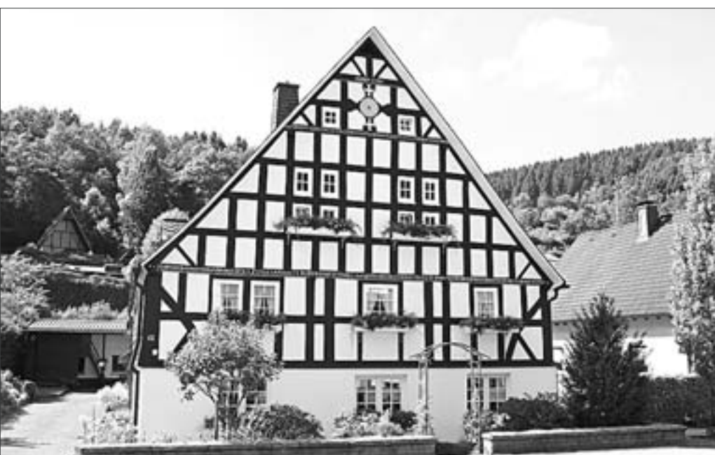
Anno 1730 steht an der Giebelwand des Hauses.
